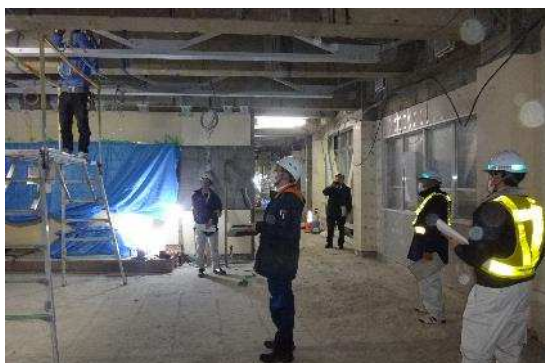
点検状況<須賀川、石川方面>
