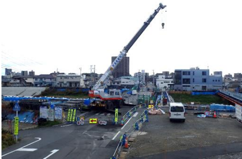
橋桁撤去工事の様子
