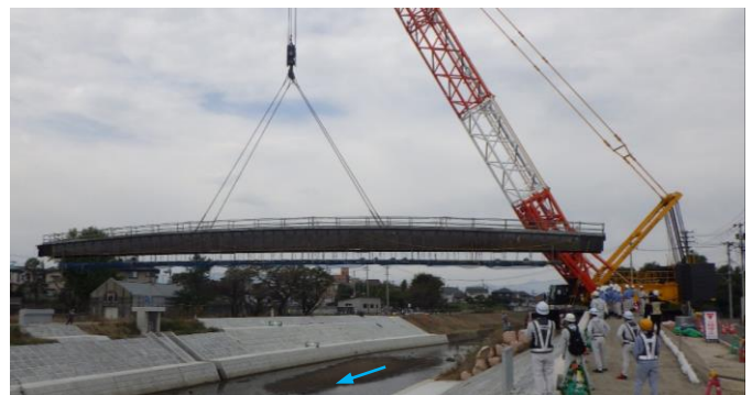
上部工の架設状況
