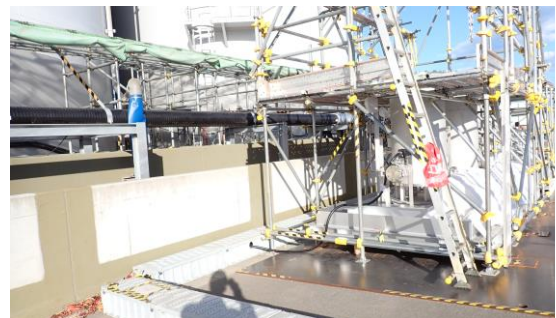
(写真1-2) K4タンクエリア南側仮設移送設備 における仮設移送配管及び雨養生カ バーの撤去状況 (令和5年11月24日撮影)
