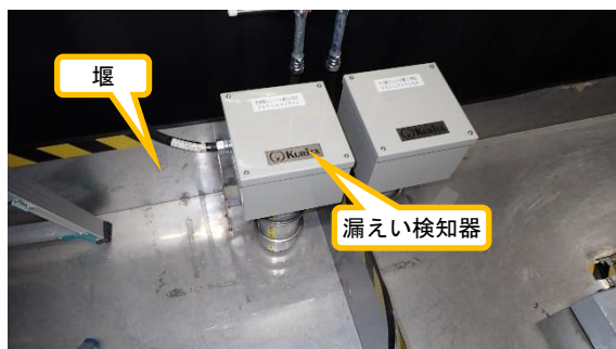
(写真3-2) 淡水化処理RO膜装置のROユニッ トC系の状況②
