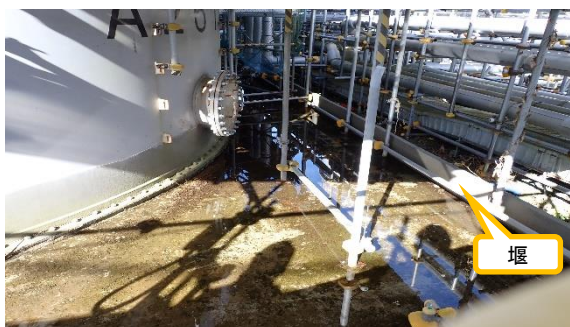
(写真4-2) 雨水受入タンクの状況
