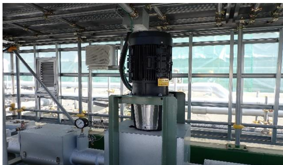
(写真6-2) 雨水回収タンクG3西D7の雨水処理用移送ポンプの状況
