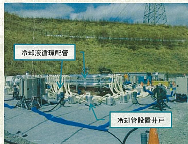
<凍結試験 現場施工状況写真>
