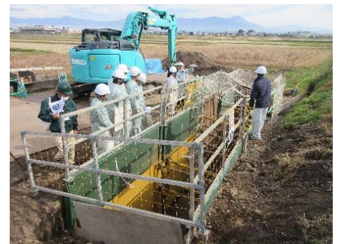
▲会津宮川地区（パイプライン）
