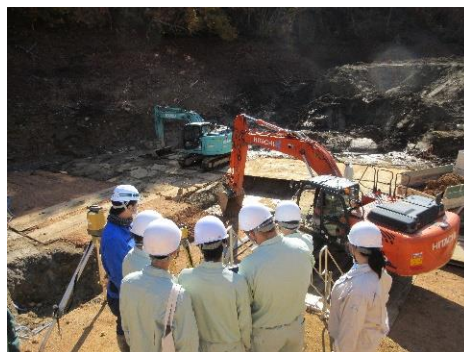
▲大窪地区（ため池改修）
