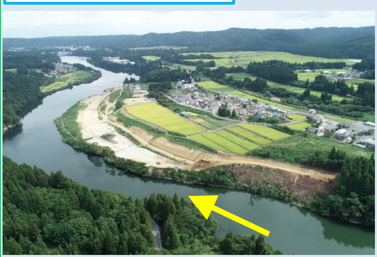
施工中（令和5年9月末時点）
