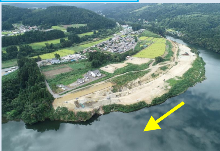
施工中（令和5年9月末時点）
