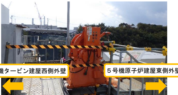
(写真3-2) 試験施工位置2-2におけるボーリング機械の設置状況 (5号機原子炉建屋屋上)
