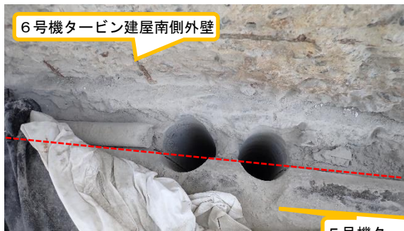
(写真 2 - 1) 試験施工位置 1 - 2 において削孔が完了した状況
