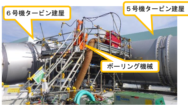
(写真3-1) 試験施工位置2-1におけるボーリング機械の設置状況 (5号機原子炉建屋屋上)
