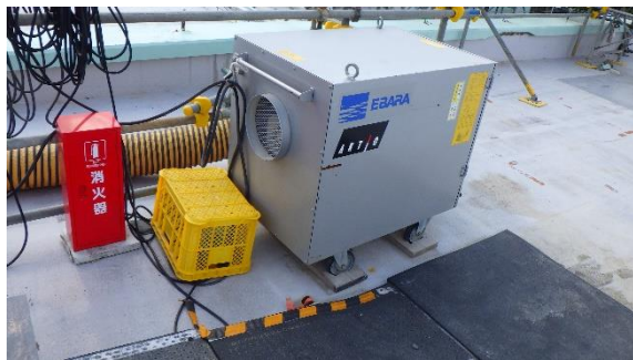
(写真4) 集じん機の設置状況 (6号機タービン建屋屋上)
