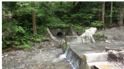
▲大林堰 土砂撤去後
