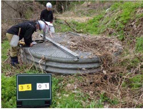
▶ 集水井工の点検状況
