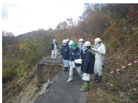
▲災害査定 下松滑沢線（西会津町）
