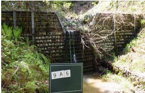
▶ 鋼製枠堰堤工の点検状況
