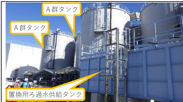
(写真1-1) K4タンクエリアの概観
