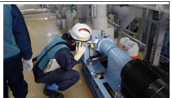
(写真1-2) 起動後の処理水移送ポンプの確認状況
