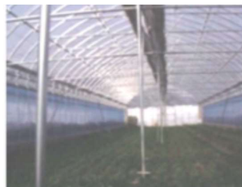
中柱（仮支柱）設置の写真
