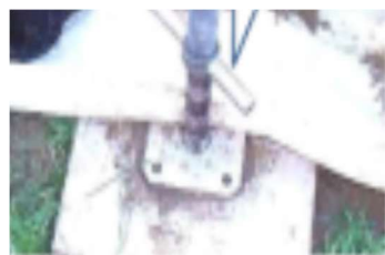
中柱（仮支柱）の根元の写真
