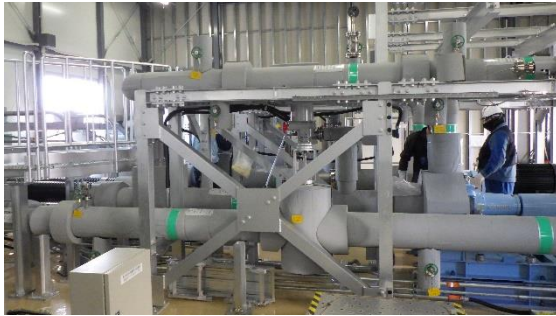
(写真4) サンプルタンク循環ポンプ周辺配管 水張りの状況
