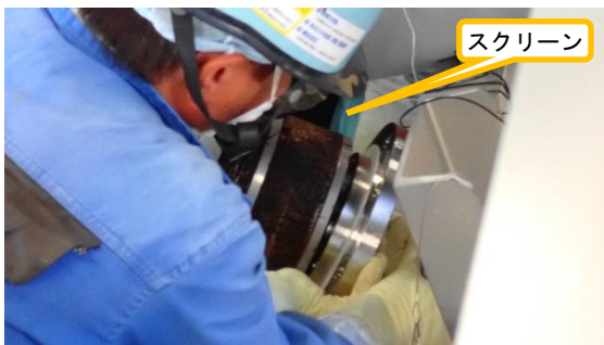
(写真6) ストレーナ内部スクリーン等取り外 しの状況（処理水移送ポンプ側）
