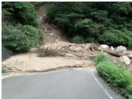
▲ 保安林から道路への土砂流出
