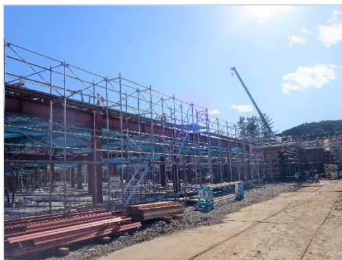
《建築工事現場》
