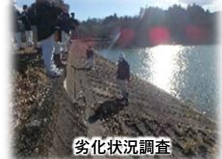
劣化状況調査
