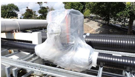
(写真3) 漏えい検知器が発報したベント弁の復旧状況
