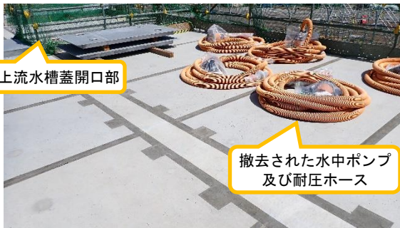
(写真1) 上流水槽蓋開口部付近の状況
