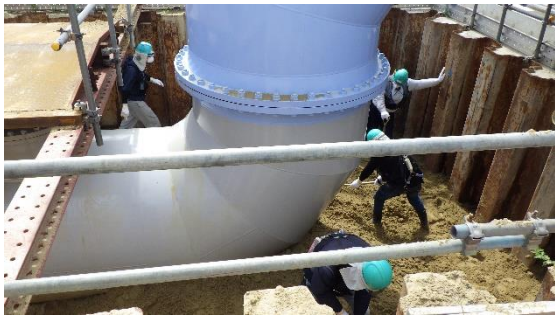
(写真 4-1) 土砂の埋め戻し状況 (令和 5 年 9 月 26 日撮影)
