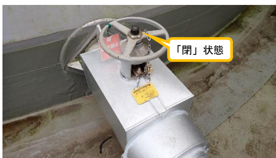
(写真1) C群処理水サンプルタンク出口弁 (ゲート弁) の状況
