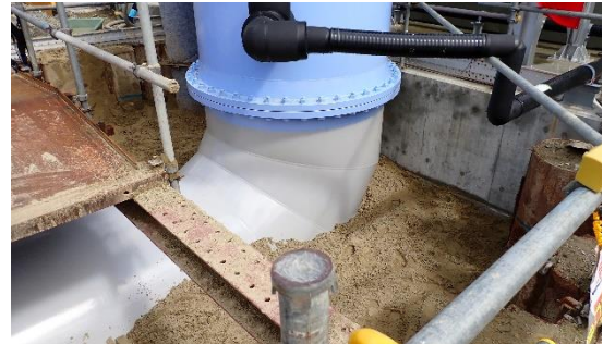
(写真 4-2) 土砂の埋め戻し状況 (令和 5 年 9 月 28 日撮影)
