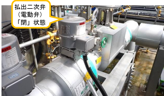
(写真 2 - 6) 払出二次弁 (電動弁) 「閉」状態 (全景)
