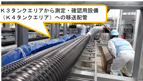
(写真 3) K3タンクエリアから測定・確認用設備 (K4タンクエリア) にALPS処理水を移送するための移送配管の敷設状況
