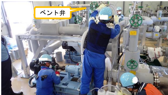
(写真1) 配管水張り作業の状況
