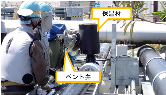
(写真4) ベント弁の保温材設置の状況
