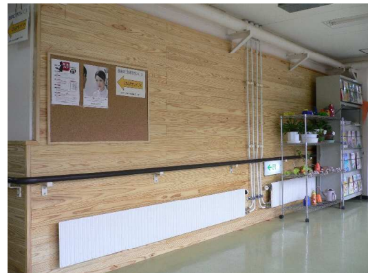
写真3 壁材の施工事例
