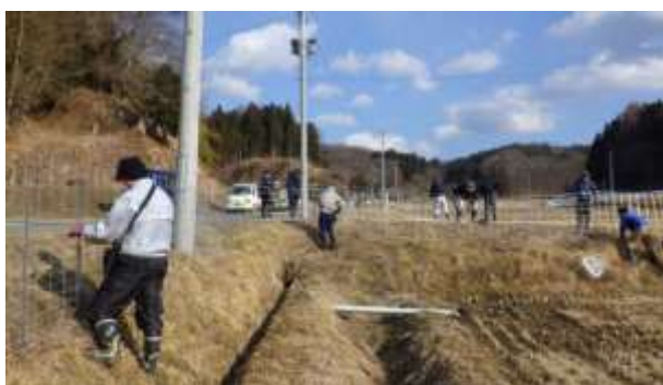
地域住民主体でイノシシ侵入防止柵を設置している様子
