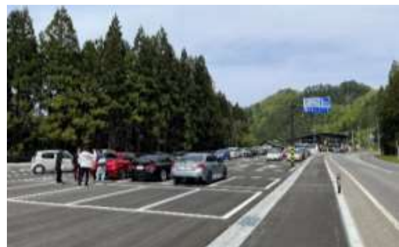
整備した道の駅尾瀬街道みしま宿駐車場(三島町)
