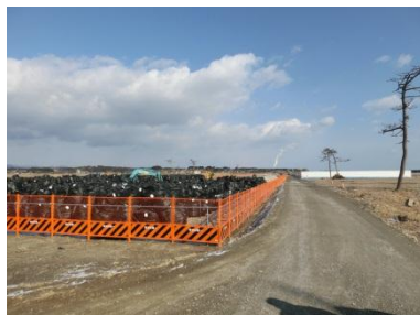
工事に使う土嚢
