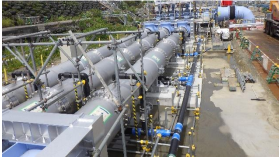
(写真5) 海水配管の状況
