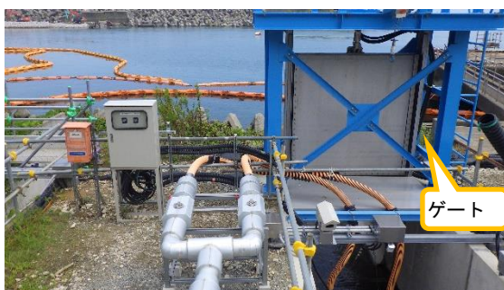
（写真3-1） D排水路最下流部の状況①
