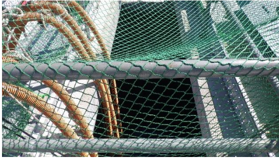
(写真1-1) 上流水槽の蓋開口部（東側）の状況
