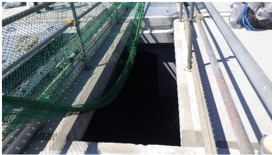
(写真1-2) 上流水槽の蓋開口部（西側）の状況
