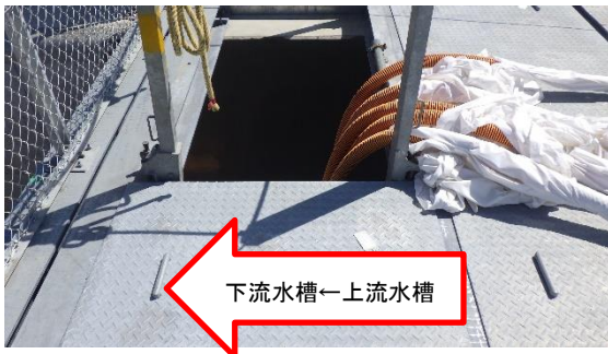
(写真2-1) 上流水槽と下流水槽の接続部上部の蓋開口部（東側）の状況（※左の耐圧ホースは写真1-1の耐圧ホースにつながっている。）
