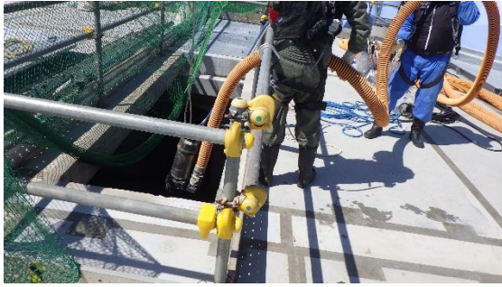
(写真3-1) 放水立坑（上流水槽）の蓋開口部 （西側）に水中ポンプと耐圧ホース を設置している状況
