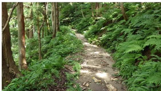
本木上堰 土砂流入状況
