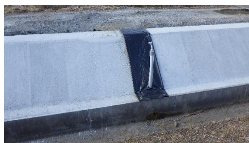
シールコンクリート工②(一部は防草シート)
