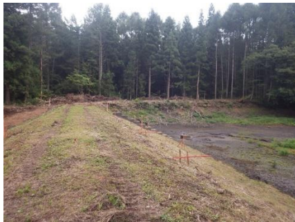
湊地区（会津若松市）防災工事施工前
