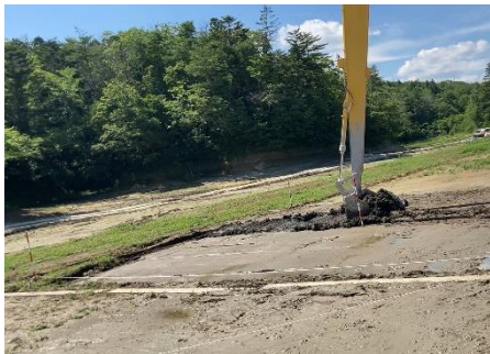
直接掘削による除去工
