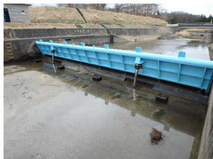
転倒ゲート塗装修繕（施工後） 大関頭首工（田村市）
