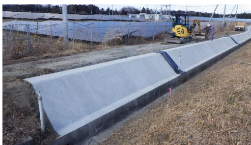
シールコンクリート工①
