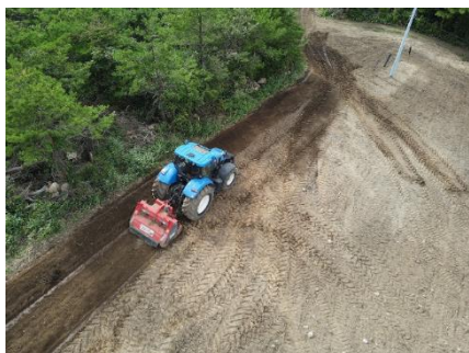
ストーンクラッシャーによる砕石作業
