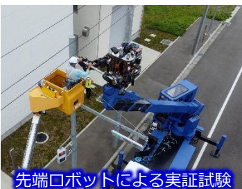
先端ロボットによる実証試験
