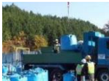
除去土壌等の車両積込状況
