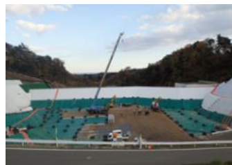
特定廃棄物埋立処分施設
