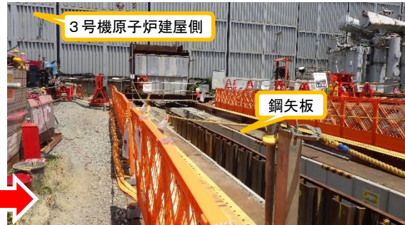
(写真1-2) 鋼矢板設置箇所の状況 (令和5年7 月26日、南西側から3号機原子炉 建屋に向かって撮影)
