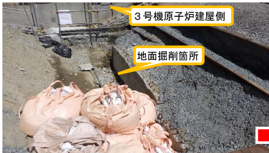
(写真1-1) 鋼矢板設置予定箇所の地面掘削状況 (令和5年4月19日、南西側から 3号機原子炉建屋に向かって撮影)
