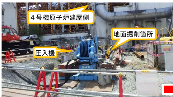
(写真1-3) 鋼矢板設置予定箇所の地面掘削状況 (令和5年4月19日、北西側から 4号機原子炉建屋に向かって撮影)
