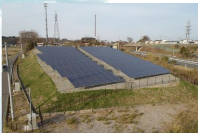
写真：太陽光発電所
