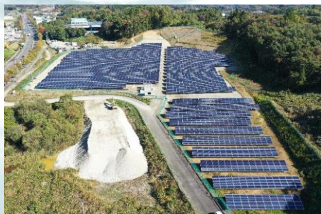
写真：太陽光発電所
