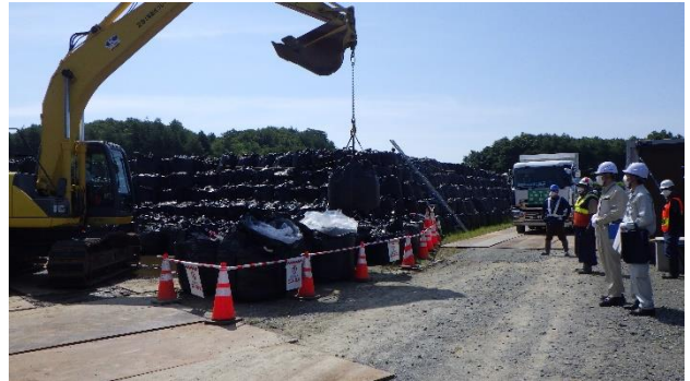
除去土壌等の積込作業
