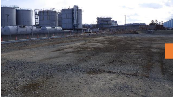
(写真3-1) DD2の状況（北側から令和5年1 月6日撮影）
