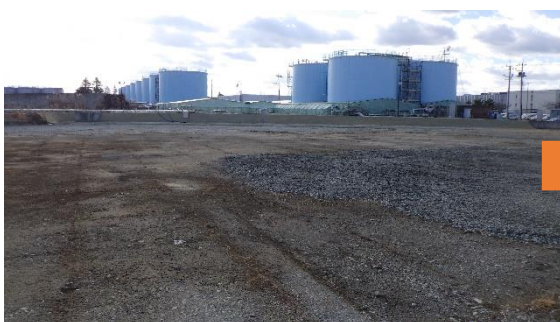
(写真2-1) DD1の状況(北側から令和5年1月6日撮影)
