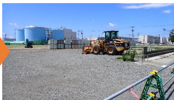
(写真2-2) DD1の状況(北側から令和5年6月29日撮影)
