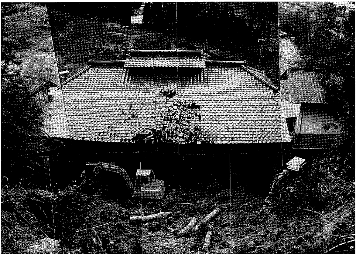
鰻内地すべり被害状況
