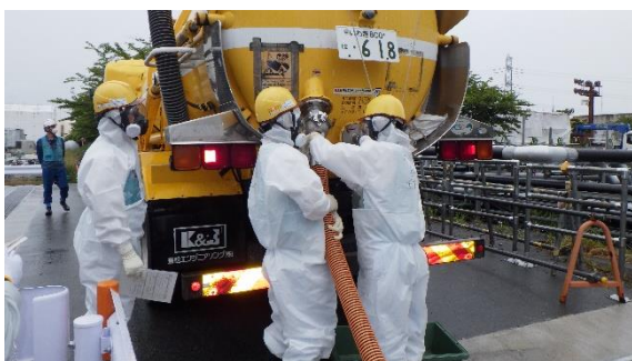
(写真 4) 高圧吸引車の操作訓練状況
