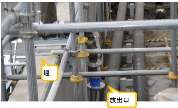
(写真 3 - 2) 移送先の増設・高性能ALPS サ ンプルタンク堰内の状況
