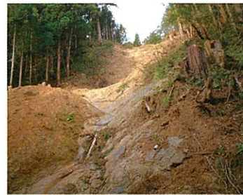
山腹斜面の崩壊(長岡市)
