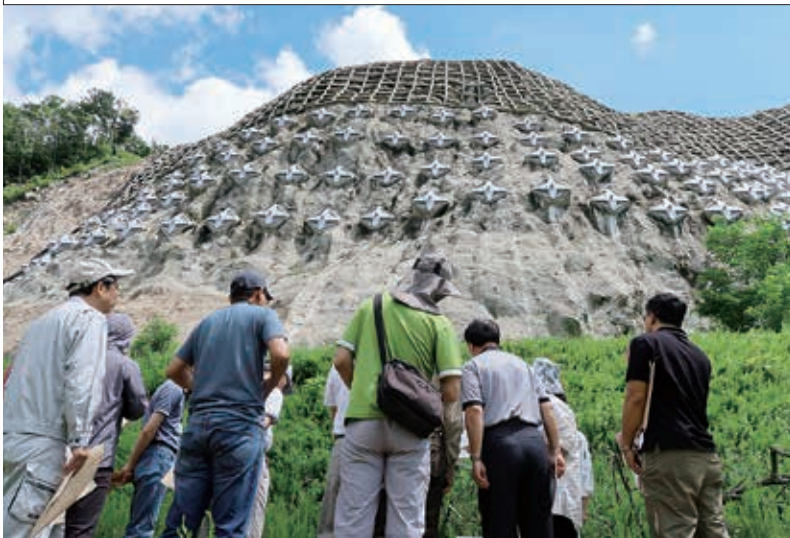
地すべり対策事業 高清水地区（福島市）視察状況
