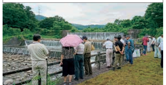
直轄砂防事業 荒川上流地蔵原堰堤 （福島市）視察状況
