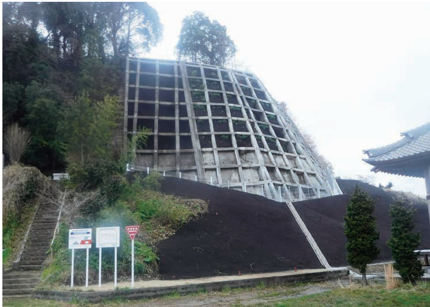
写真：急傾斜地崩壊対策事業 搦町地区（いわき市小名浜住吉地内） 令和2年度概成
