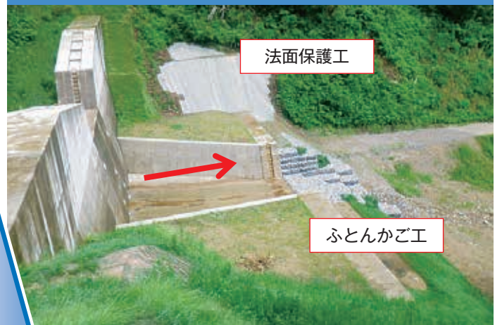
【after】整備状況(平成31年3月)
