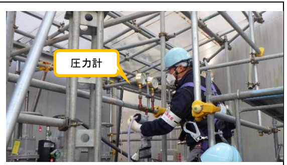
(写真 1-2) 耐圧試験の状況
