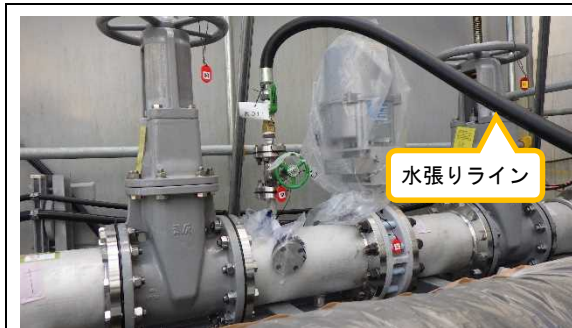
(写真 1-1) 耐圧試験の状況
