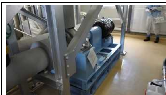
(写真1) 循環ポンプの設置状況
