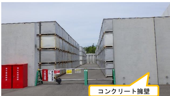
(写真1-1) 一時保管エリアA1の状況
