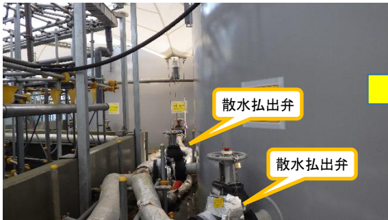
(写真 2 - 1) 雨水処理水タンク B の散水払出弁の 状況 (前回(令和4年1月5日)西側から 撮影)
