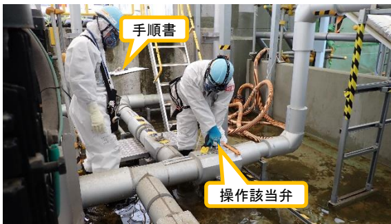
(写真 2 - 1) 雨水処理水タンク B の散水払出弁の 状況 (前回(令和4年1月5日)西側から 撮影)
