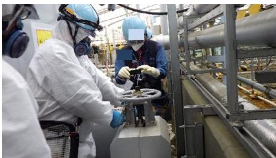
(写真 4) 雨水処理水タンク A の散水払出弁の 「解錠」操作の状況
