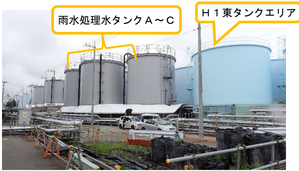
(写真 1) 雨水処理水タンク A～C の外観 (南東側から撮影)
