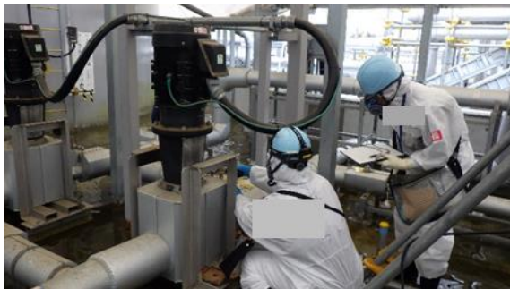
(写真 5 - 3) 散水ポンプ稼働後の確認状況
