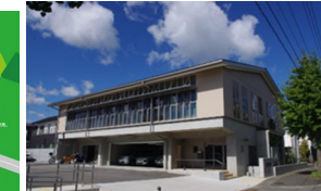
须贺川土木事务所政府大楼获得东北首个“Nearly ZEB”认证。实现87%的能源消耗量削减。
