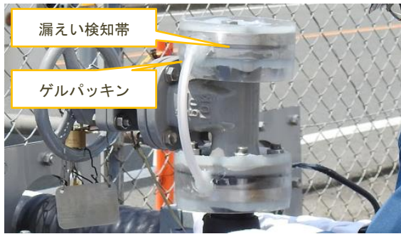
(写真 2 - 4) 据付検査の状況② 写真 2 - 3 の拡大
