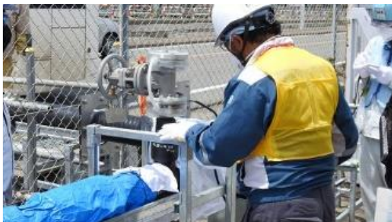
(写真2-3) 据付検査の状況①
