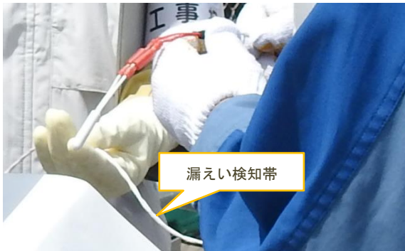
(写真2-2) 外観検査の状況② 写真2-1の拡大
