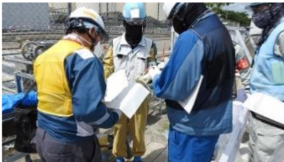
(写真2-1) 外観検査の状況①
