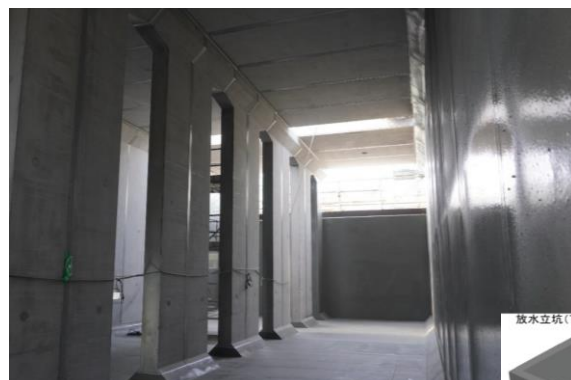
上流水層内部の状況 (防水塗装完了)
