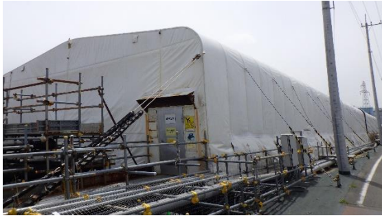
(写真1) 淡水化装置RO3建屋（ジャバラハウス）外観 （北東側より撮影）
