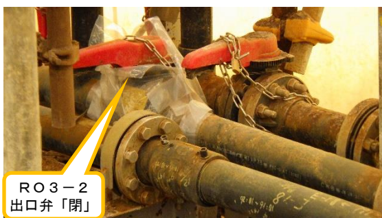
(写真4-1) RO3-2 出口弁の状況「閉」 (前回撮影：令和5年2月28日)
