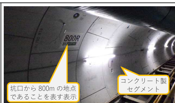
（写真 1-2）放水トンネル内の状況
