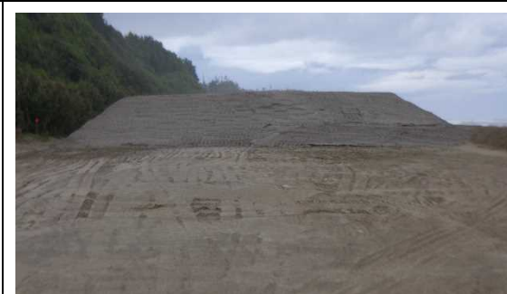
（写真 3）浚渫された土砂の仮置き状況
