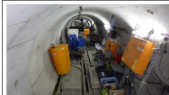
（写真 2）掘削作業で使用した設備等の状況
