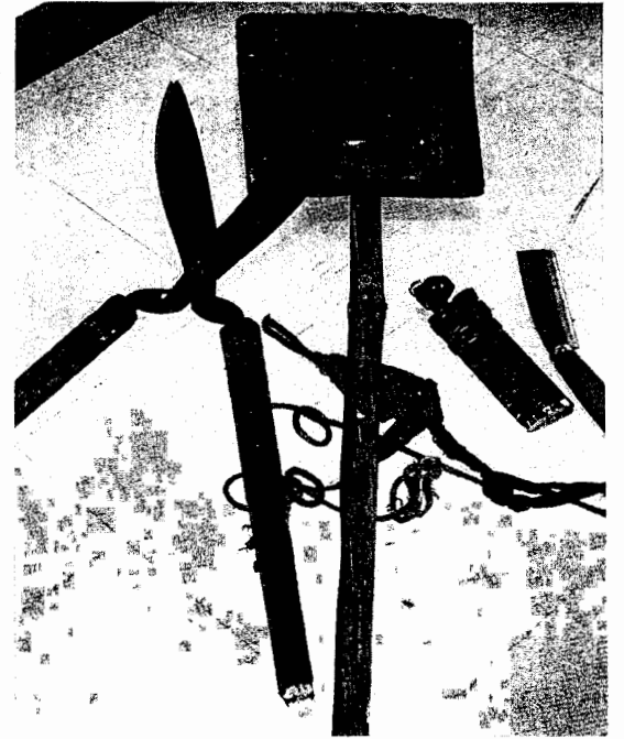
3-61 萱手が使用した道具 萱屋根の葺き替えや修理する職人には、道具として、鋏、鉋萱抜、皮通し、鉤、針、サシヘラが必要だった。
