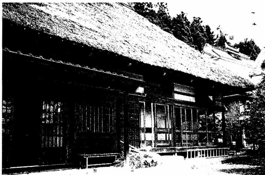
2-26 戦前に建てられた浅川町の民家 浅川町の民家、とくに農家は萱葺きの家が多かった。当町に現在残されている萱葺きの家は、明治の初期から戦前にかけて建てられたものが多い。
