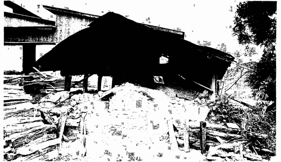
3-68 炭焼きにとって大事な窯打ち 炭焼きは、窯を打つ場所の選定から始まり、次の条件として湿度の少ない所、土質も重要である。
