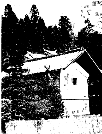
2-39 白壁土蔵 石灰に綿つた、ふのりをすでふるい煮て、その汁を綿つたに混ぜて練る。それに石灰を混ぜて、砂壁の上に塗る。これを白壁という。
