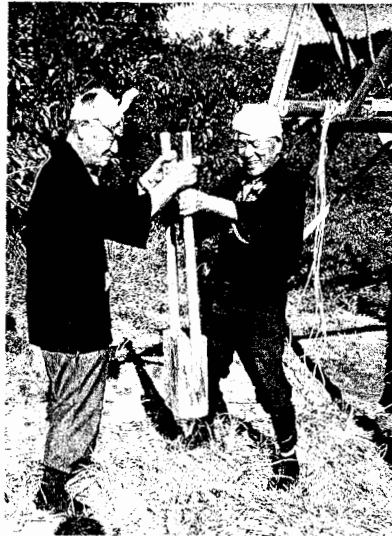
2-33 たこ突き たこ突きで、土固めをしている風景。
