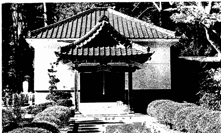
8-106 ミイラを祀る薬師堂 小貫の貫秀寺境内にあり、お堂は大正14年（1923）に建てられたものである。観音寺が火災で焼失したため、宥貞法印のミイラがここに移された。
