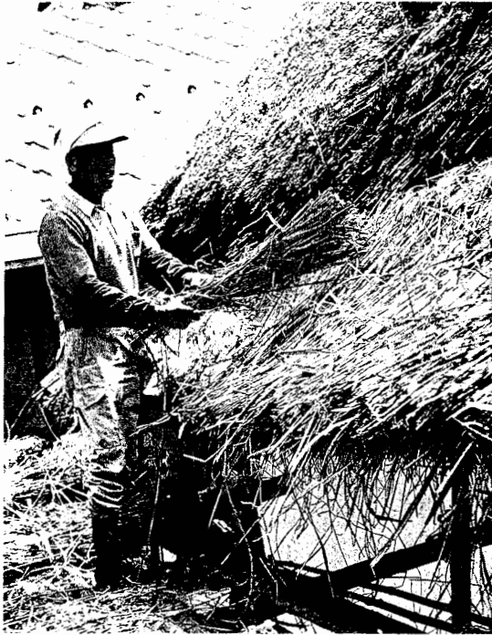
3-62 萱屋根の補修 萱や小麦藁を使って、雨漏り箇所の補修。
