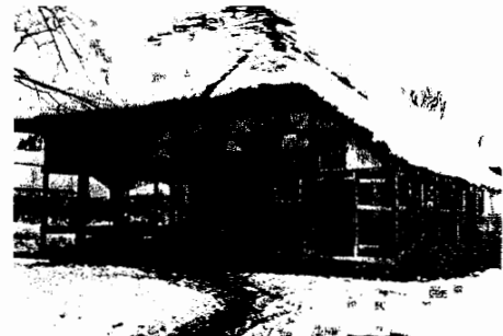
【写真77】松倉宝蔵院解体前・昭和39年（提供 藤田忠一）
