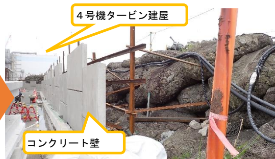
(写真2-2) 4号機南側における日本海溝津波防潮堤の防潮堤本体工事の状況（南西側から令和5年5月25日撮影）
