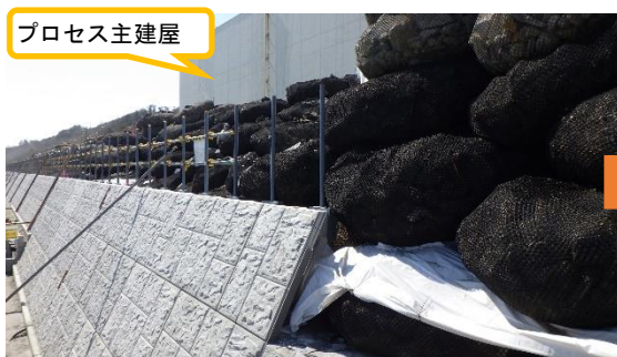
(写真1-1) 4号機南側における日本海溝津波防潮堤（アウターライズ津波防潮堤の法面補強）の状況（北東側から令和5年3月1日撮影）
