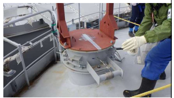
(写真4) ワイヤーによる固定の状況
