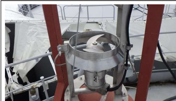
(写真1) 投入前の攪拌器の状況
