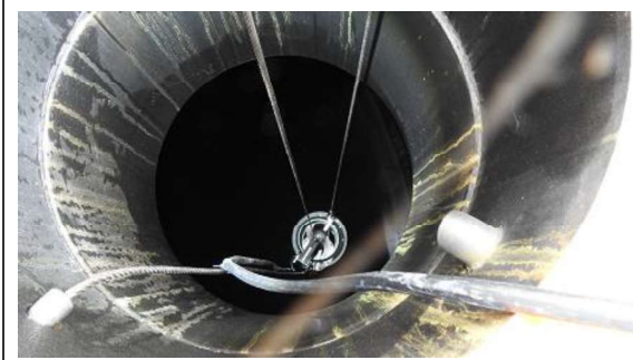
(写真3) 攪拌器の吊り下げ状況
