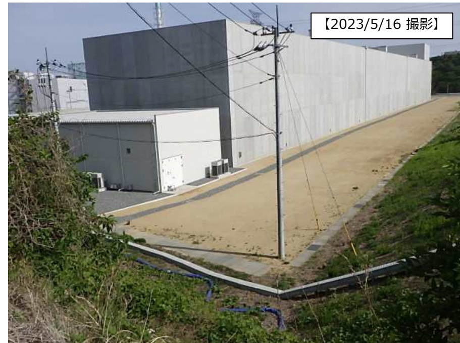
【現場状況：南東側より撮影】
