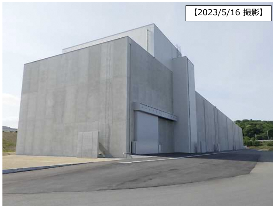
【現場状況：北西側より撮影】
