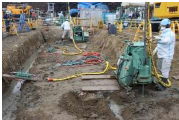
地盤改良の状況
