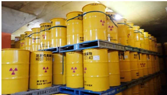
(写真1-2) 第6棟(北側)における廃棄物 保管の状況(2)
